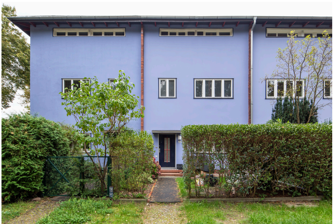
Abb. 15 | 2021 Einfamilienhäuser von Otto R. Salvisberg in Bauabschnitt II, hier wurden die bztl. Holzlamellen im Dachgeschoss entfernt und Fenster in die Öffnung eingesetzt.
